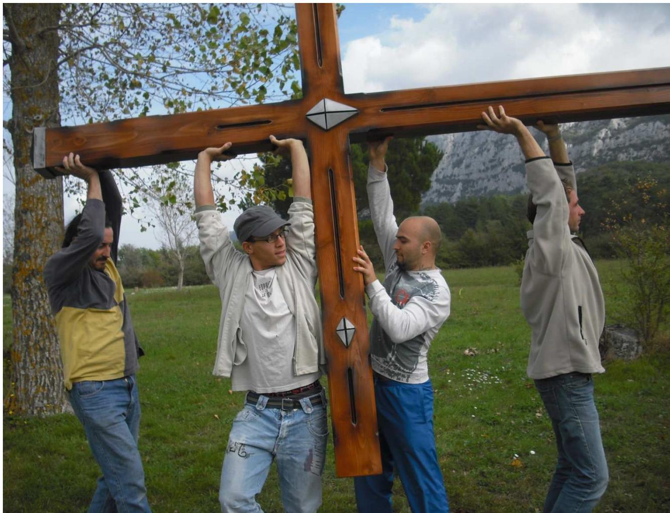
Elle a 4,80 m de haut (soit 1,80 de plus que l'ancienne), de section 19 cm sur 14 cm, fixée sur une pièce métallique spéciale au  $\frac{3}{4}$  noyée dans un socle de béton armé de 90 cm au cube entièrement enterré.
