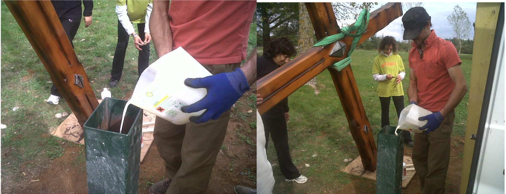
Liquide spécial de collage et d'étanchéité mis dans le fourreau avant d'y glisser le pied de la Croix.
