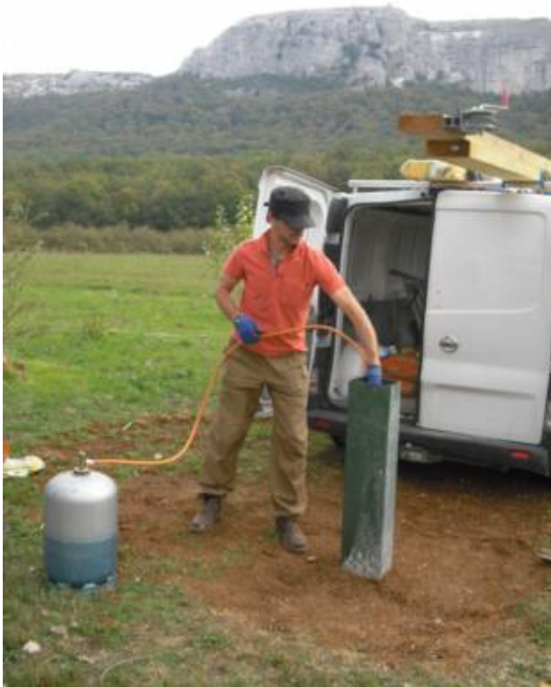
Sauveur chauffe le fourreau avant d'y mettre du goudron.
